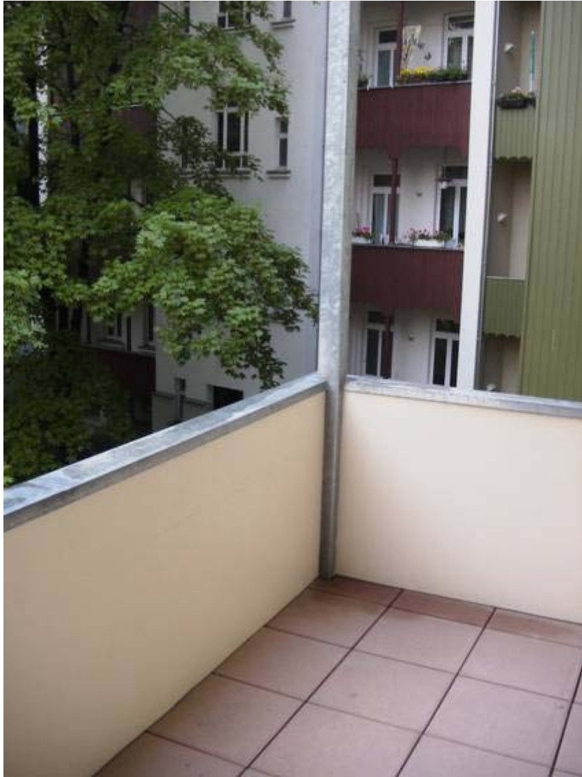
Wurzner Strasse 174, Wohnung 2.OG links
